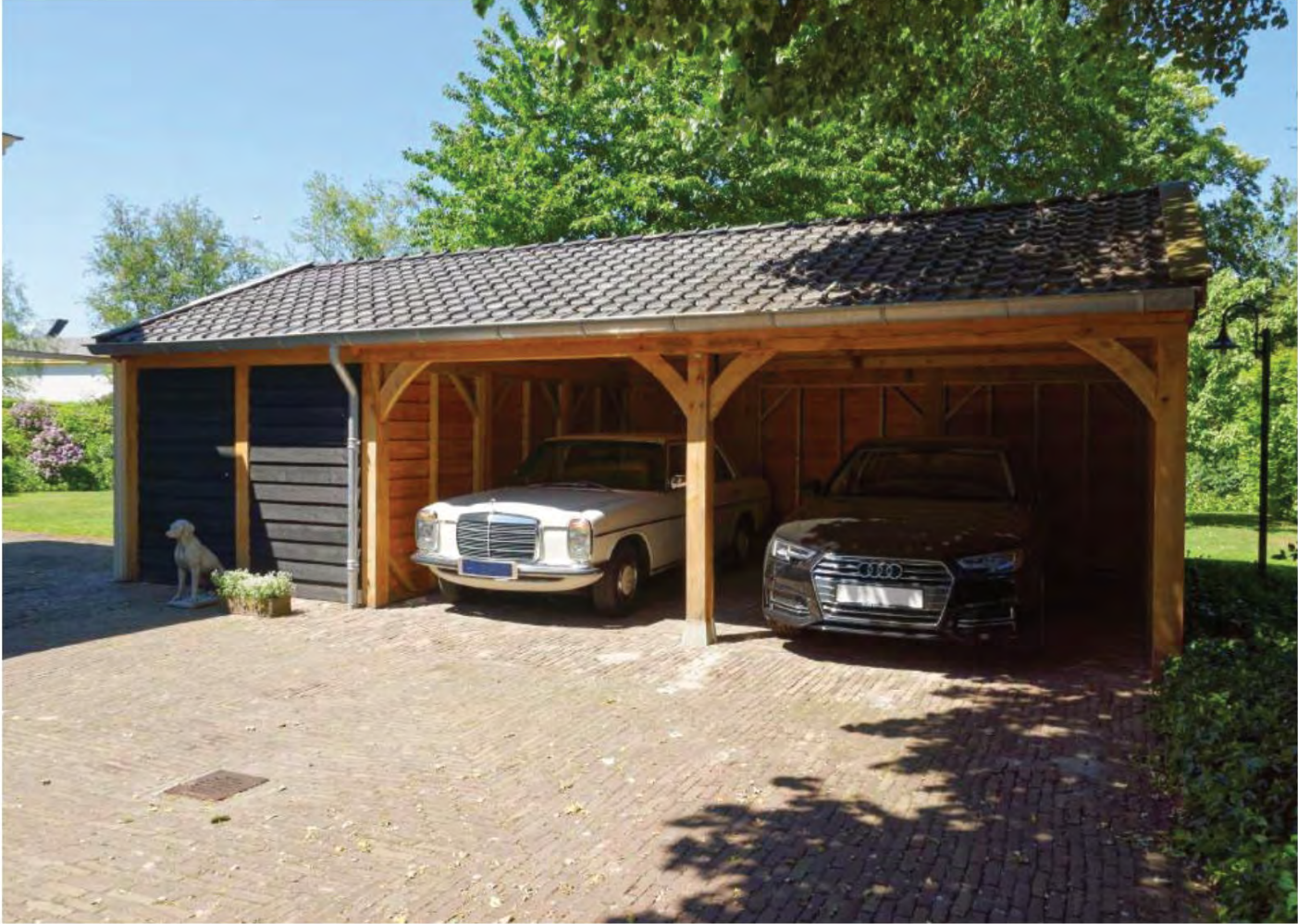
autoschuur en bergingen
