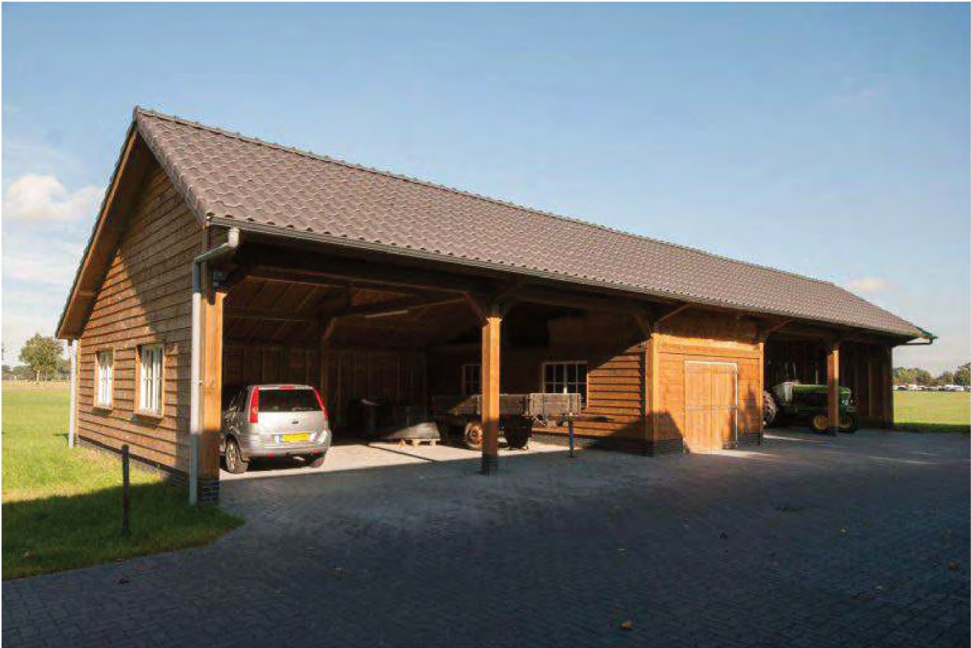
autoschuur en bergingen
